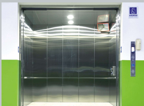
▲ 車廂：髮紋不鏽鋼 (無障礙設備) 地板：不鏽鋼花紋鋼板
