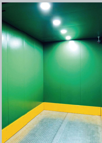
▲ 車廂：烤漆鋼板+防撞板 地板：鍍鋅花紋鋼板
